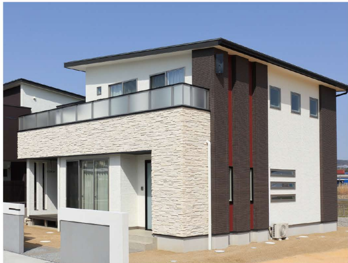
アクセントタイル貼り：玄関正面にL型に貼られた立体的なタイルが高級感を醸し出す。
